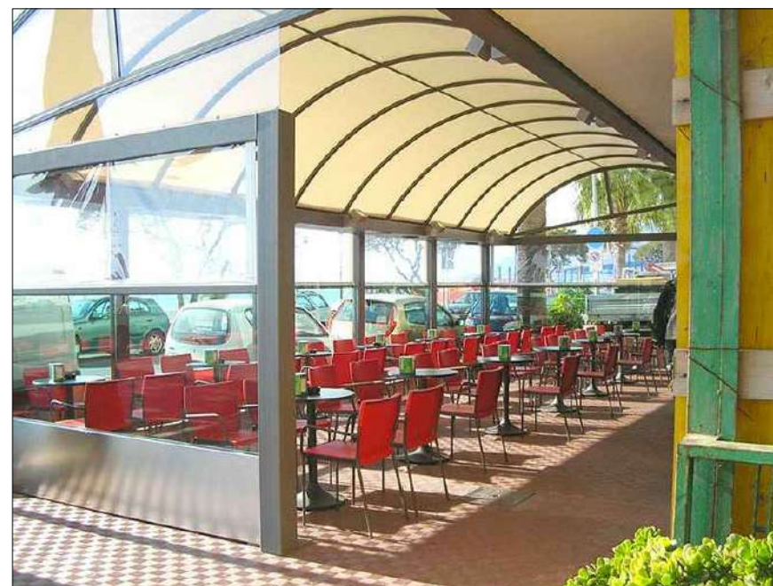
Coperture e chiusure verticali in plastica o in alluminio anodizzato
