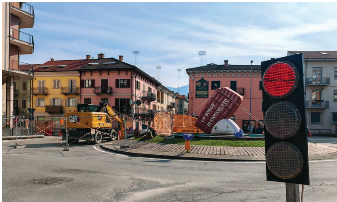
Lavori in corso e modifica della viabilità in Largo Argentera.
