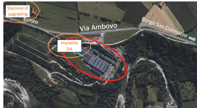
Aree ACSR interessate dall'intervento. La stazione di upgrading è l'impianto che serve a comprimere, raffreddare e purificare il gas metano per essere messo in rete
