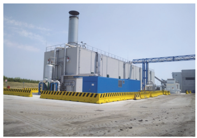
Esempio di digestore tipo: altezza, camino compreso, 8 metri
